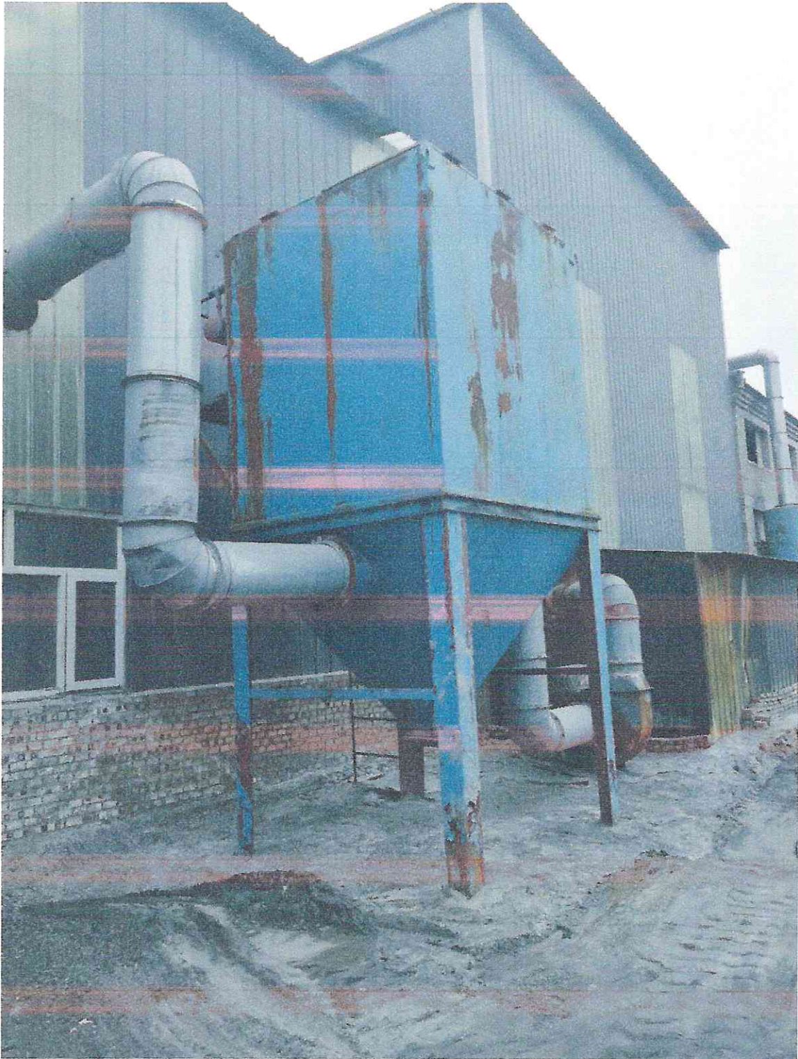
附图 3 除尘器+排气筒
