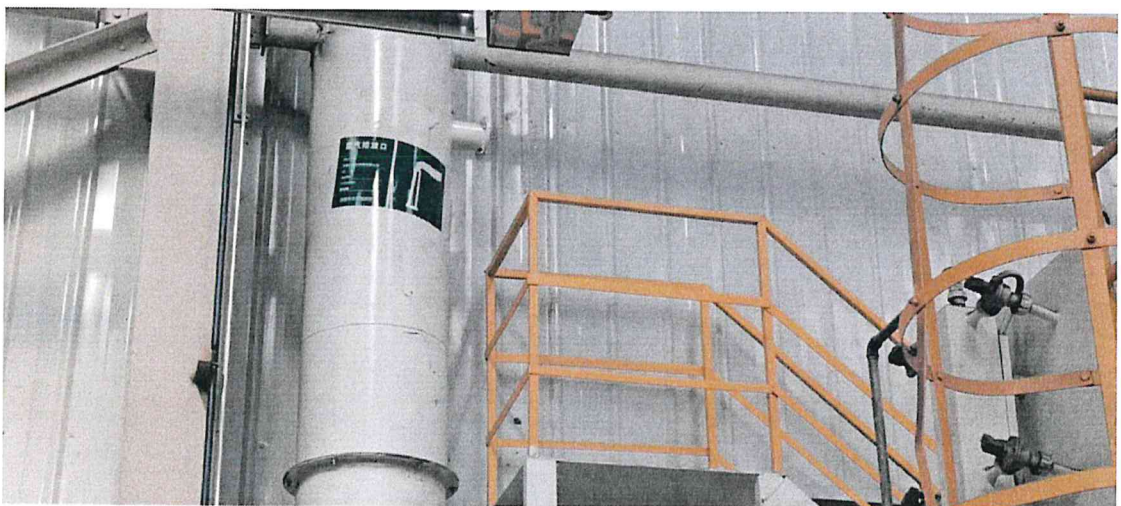
P1 喷砂、抛丸工序排气筒
