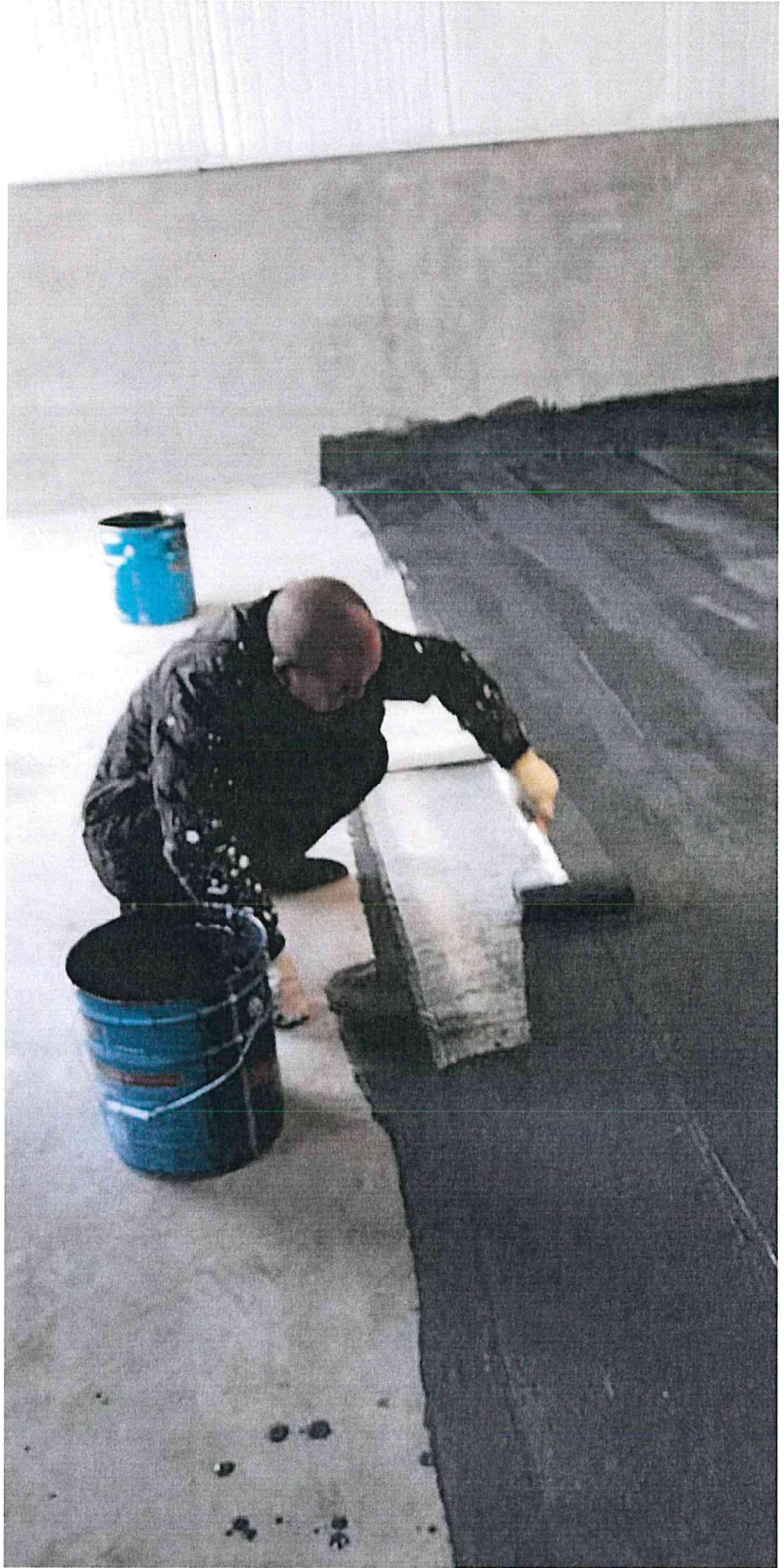
危废间施工照片
